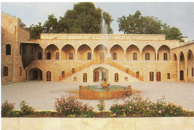
Fachada de Dar al Kataba
